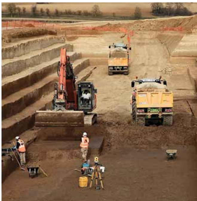
Illustration 2 : décapage mécanique fin
