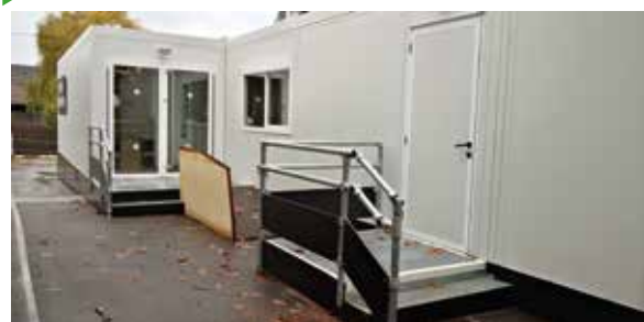
Rampe d'escalier et entrées
