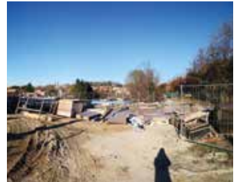
Travaux nouvelle école
